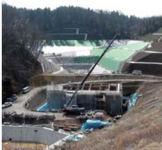
新不燃物最終処分場建設事業
