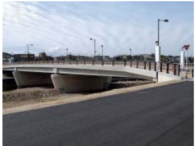
公園線整備事業(明徳橋)
