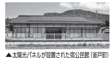
▲太陽光パネルが設置された宿公民館(釜戸町)
