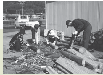
竜吟峡の散策道に使用する 木材の皮むき作業
