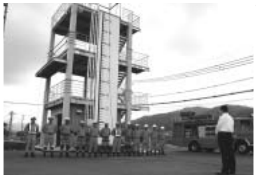
消防庁舎改築（救助訓練塔）
