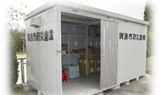
防災倉庫(瑞浪市)
