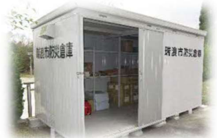
防災倉庫(瑞浪市)
