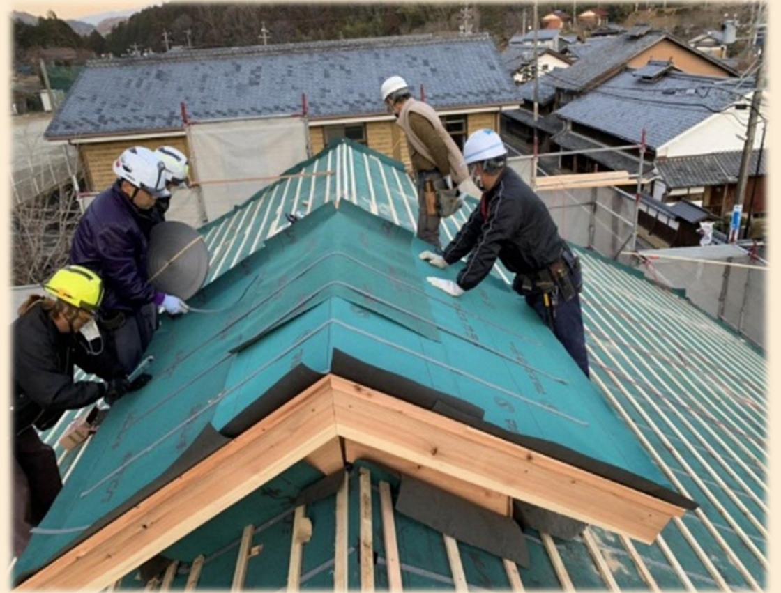
屋根改修工事
