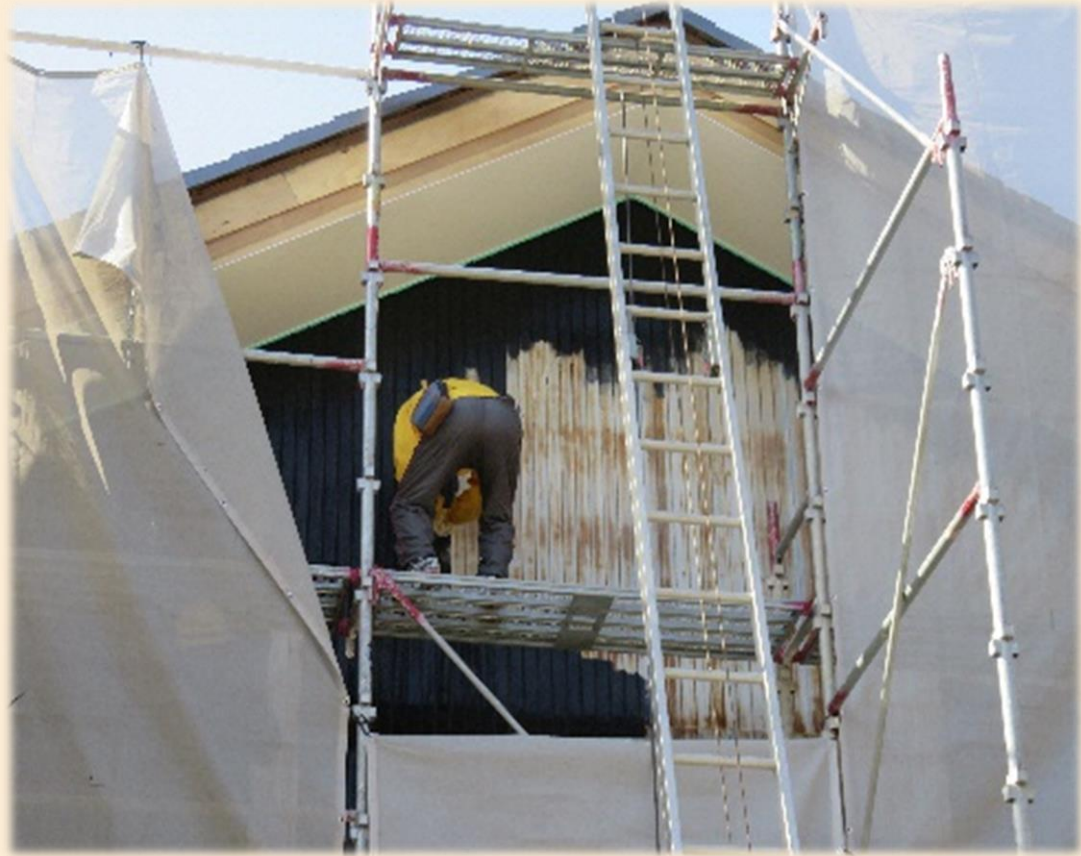
トタン塗装工事
