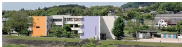
第1期工事用の黒い防護ネットが外された土岐小学校校舎
