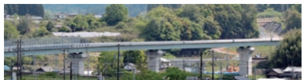
鶴ヶ城登城口から望む完成した瑞浪恵那道路の陸橋
