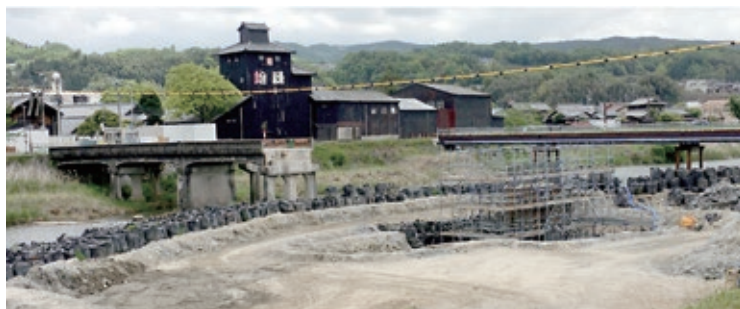
架け替え工事が進む土岐橋
