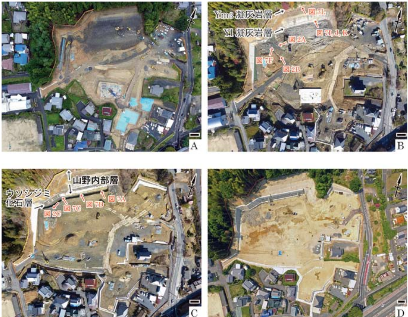
図1. 工事現場の航空写真。A, 2016年9月29日撮影；B, 2016年11月29日撮影；C, 2017年2月24日撮影；D, 2017年5月29日撮影。赤矢印は各写真の撮影位置と方向。スケールは10m。
