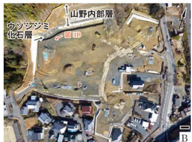
図 2. 瑞浪北中学校造成工事現場の空中写真 A：2016 年 11 月 29 日撮影。B：2017 年 2 月 24 日撮影。写真中の赤矢印は図 2 と図 6 における各写真の撮影位置と方向。スケールは 10 m。
