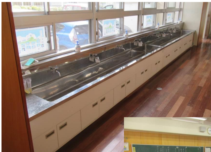
【旧日吉中学校転用改修事業】 廊下の流しの高さ変更
