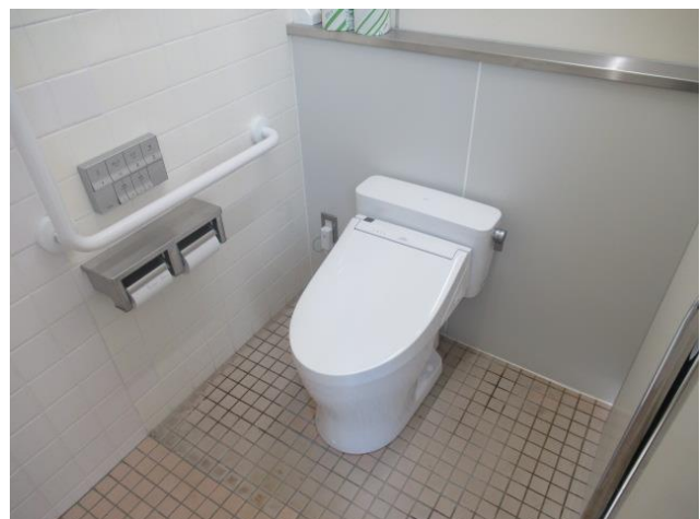
和式から洋式に改修されたトイレ
