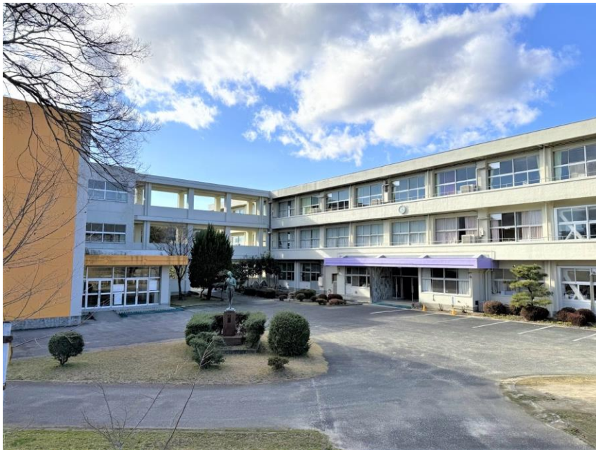
大規模改修後により外壁等がきれいになった校舎
