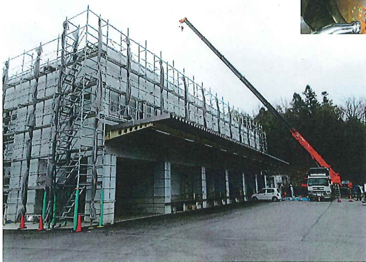
学校給食センター外壁防水等改修工事
