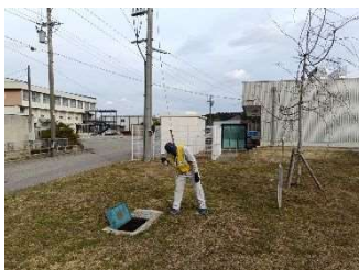
弁栓の調査の様子
